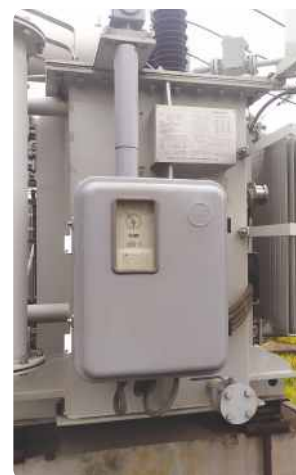
Цифровой привод с шаговым двигателем SHM-D(L)
