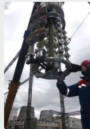
Монтаж нового РПН Huaming типа CV или CM с овальным фланцем
