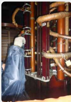
Отсоединение регулировочных отводов, маркировка отводов
