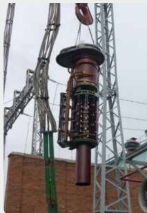
Демонтаж старого РПН
