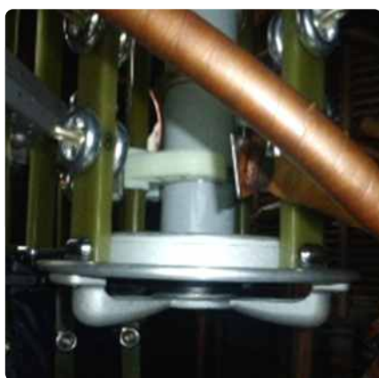
Присоединение регулировочных отводов к РПН в соответствии с маркировкой
