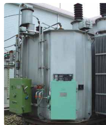
Проверка коэффициента трансформации, заполнение маслом и другие необходимые испытания трансформатора
