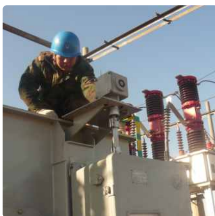
Монтаж моторного привода, синхронизация РПН и привода, монтаж маслофильтровальной станции (опция)
