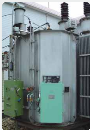
Отключение, заземление, слив масла и организация доступа к РПН
