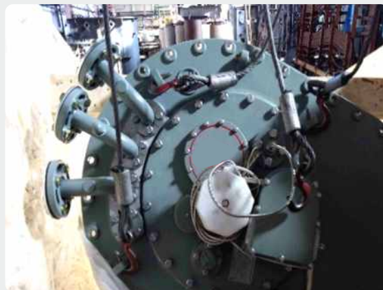
РПН типа CV с овальным фланцем для установки взамен РС-3 и РС-4
